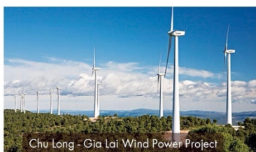
◎ DỰ ÁN ĐIỆN GIÓ CHU LONG - GIA LAI
