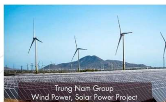
☉ CÁC DỰ ÁN ĐIỆN GIÓ, ĐIỆN MẶT TRỜI TRUNG NAM GROUP
