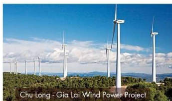
☉ DỰ ÁN ĐIỆN GIÓ CHU LONG - GIA LAI
